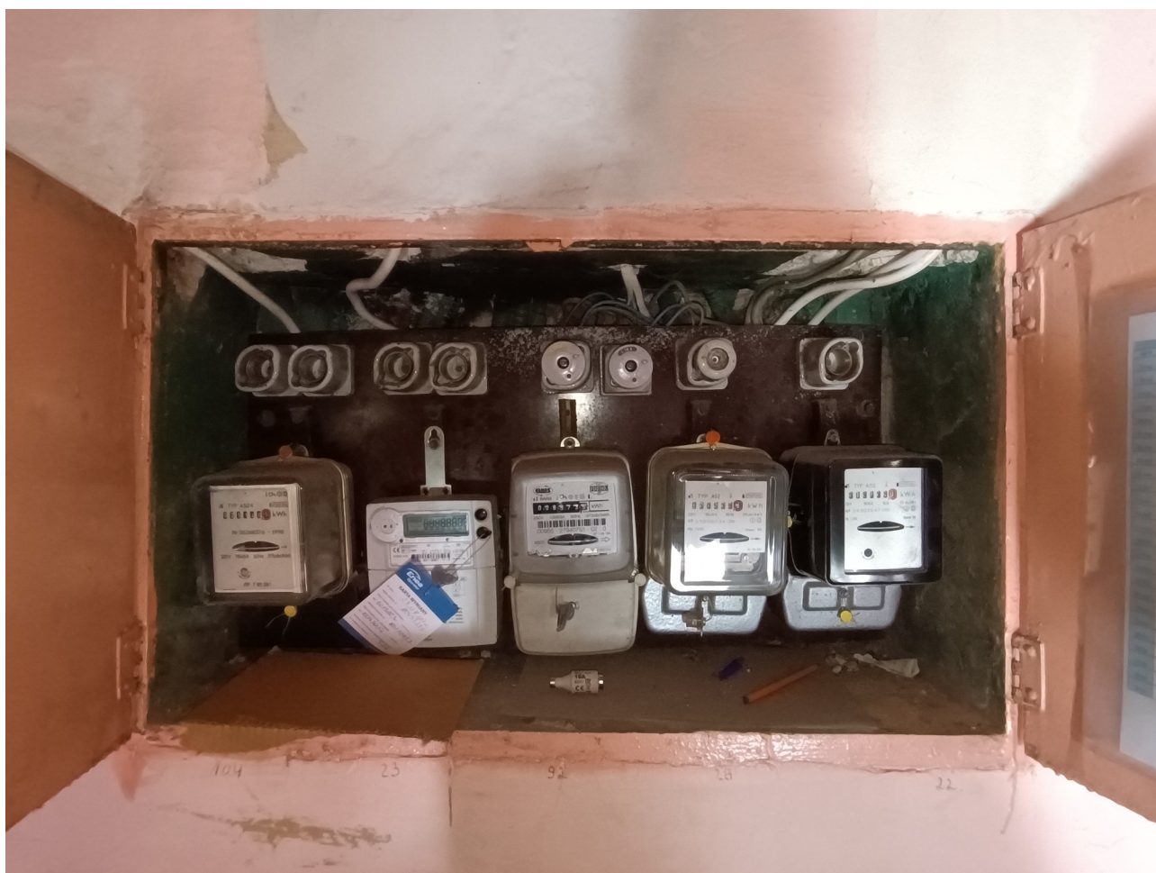
Rozdzielnica na I piętrze klatki schodowej do modernizacji
