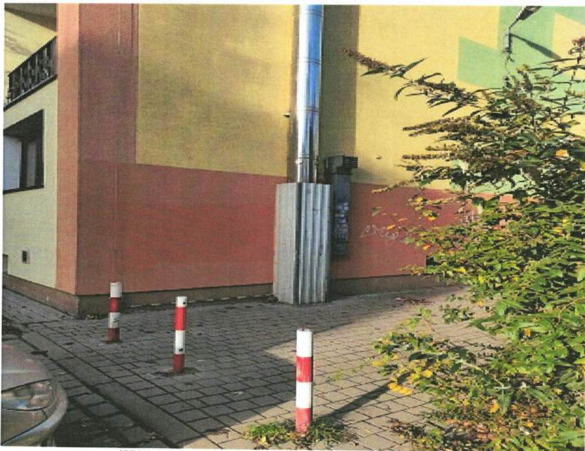
Widok budynku wraz z przewodem kominowym z kotłowni
