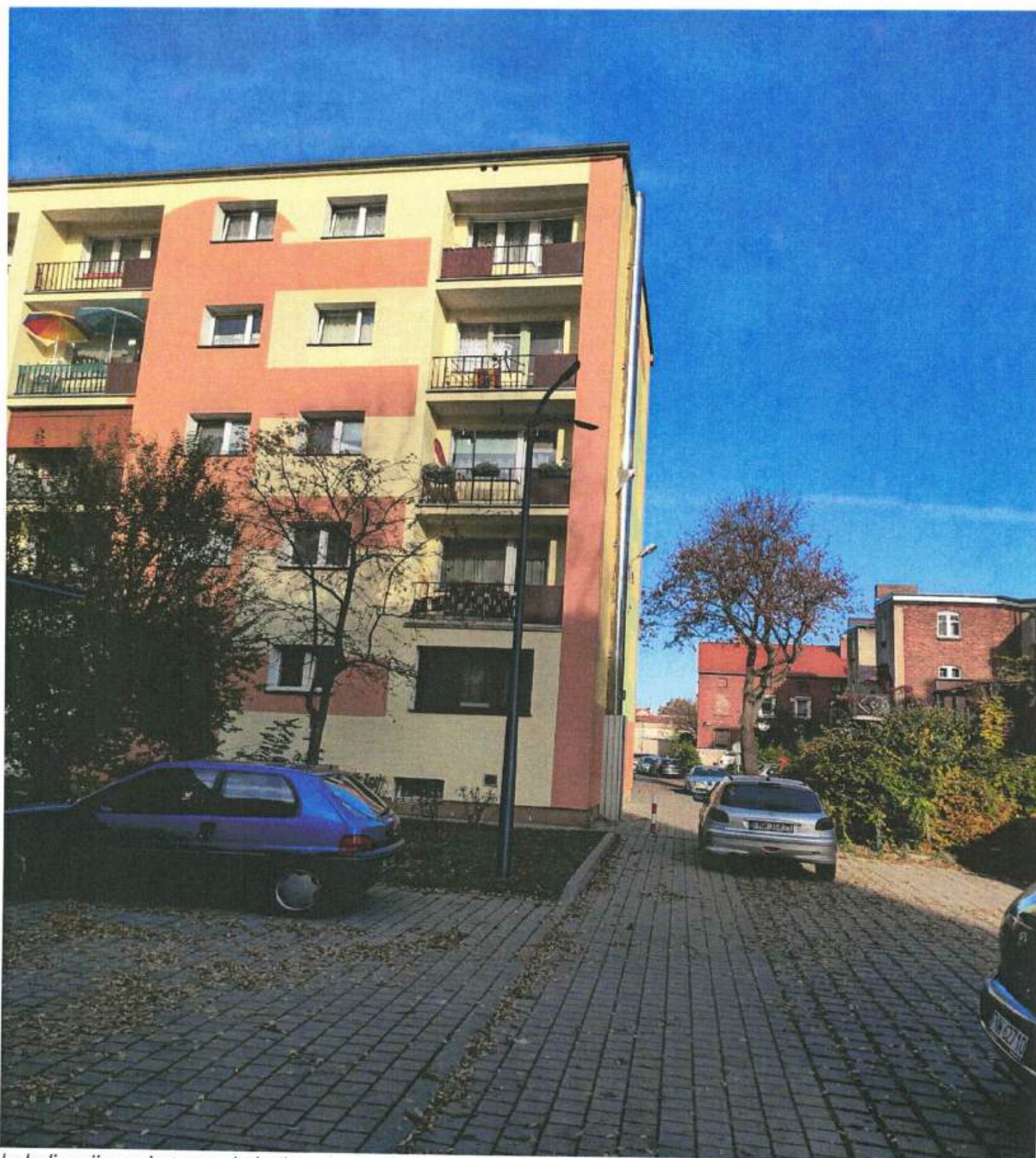
Lokalizacji pomieszczenia kotłowni w trakcie modernizacji kotłowni – narożnik prawy budynku, przy wyjściu
