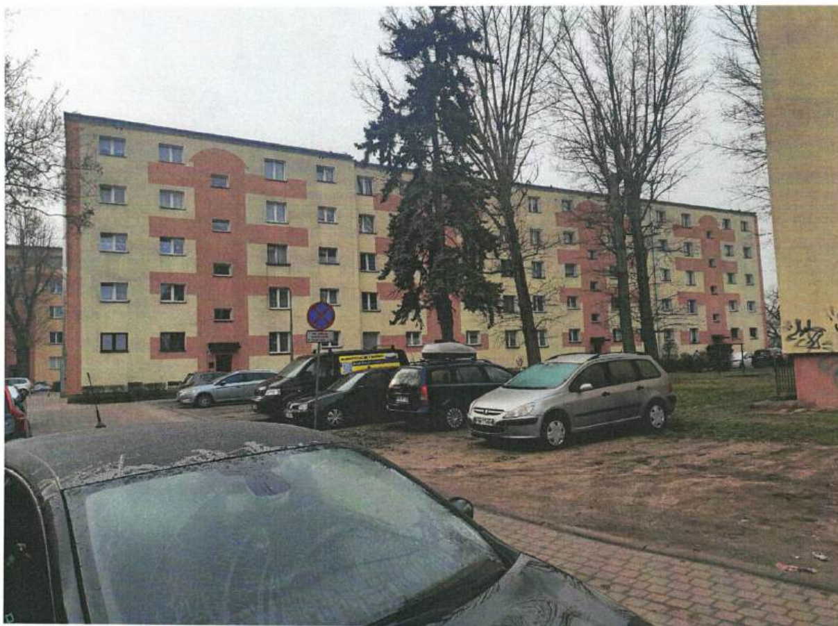
Widok budynku od strony ul. Zamenhoffa
